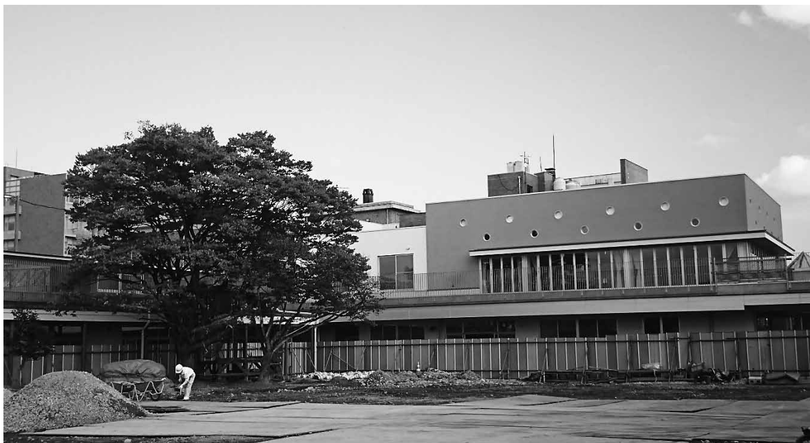
園庭だった場所に完成した新園舎。旧園舎跡は園庭づくりの工事中。 けやきの木が、移り変わりを見守っています。
